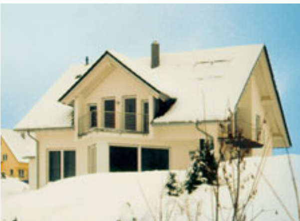
Innen schön warm, außen Winter wie im Bilderbuch. In Regionen mit strengen Wintern setzt man schon lange auf die Vollflächendämmung. Übrigens: Schnee auf dem Dach ist ein sichtbarer Beweis für gute Wärmedämmung.
